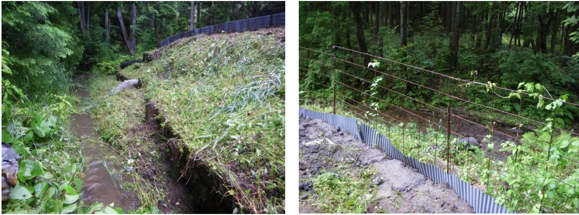
図 2. 哇波シートを水域の周囲のイノシシ侵入防止柵の下部にはりめぐらし、ザリガニ返しとして川からの遡上を防止した。
